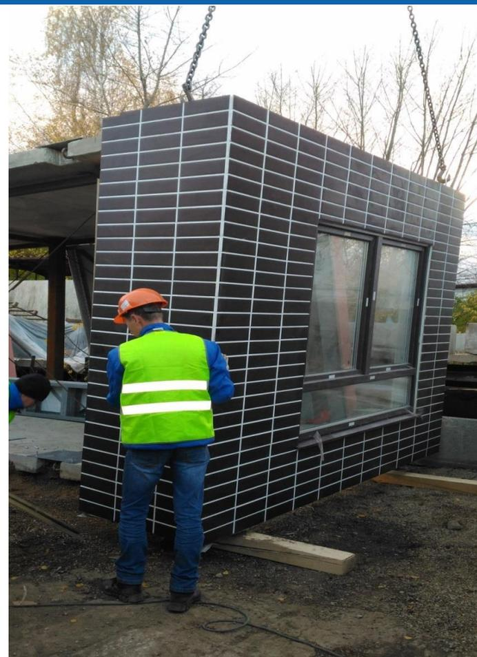
Проектирование и производство фасадных панелей для застройщика “ПИК”, Москва.
